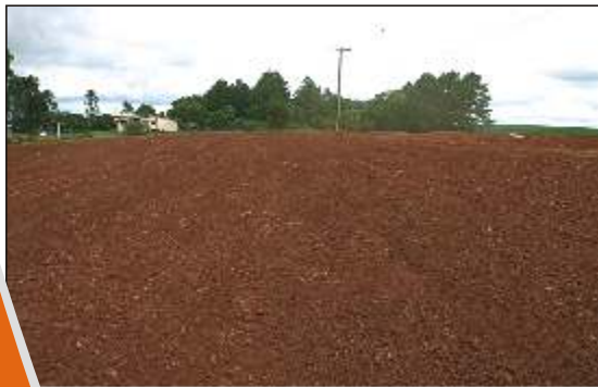
Nivelamento do solo em uma única operação.
